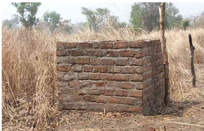
Základy dosud nedokončené platformy pro pozorování hrochů, kterák vycházejí večer na břeh se pást.
