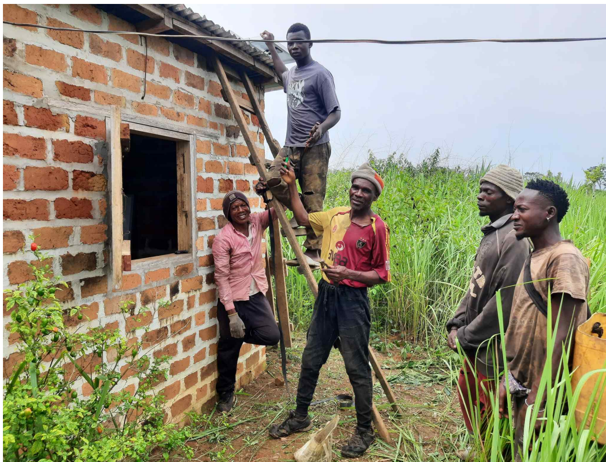
Místní rolníci z Leboulou při opravě zařízení a instalaci nového solárního panelu
