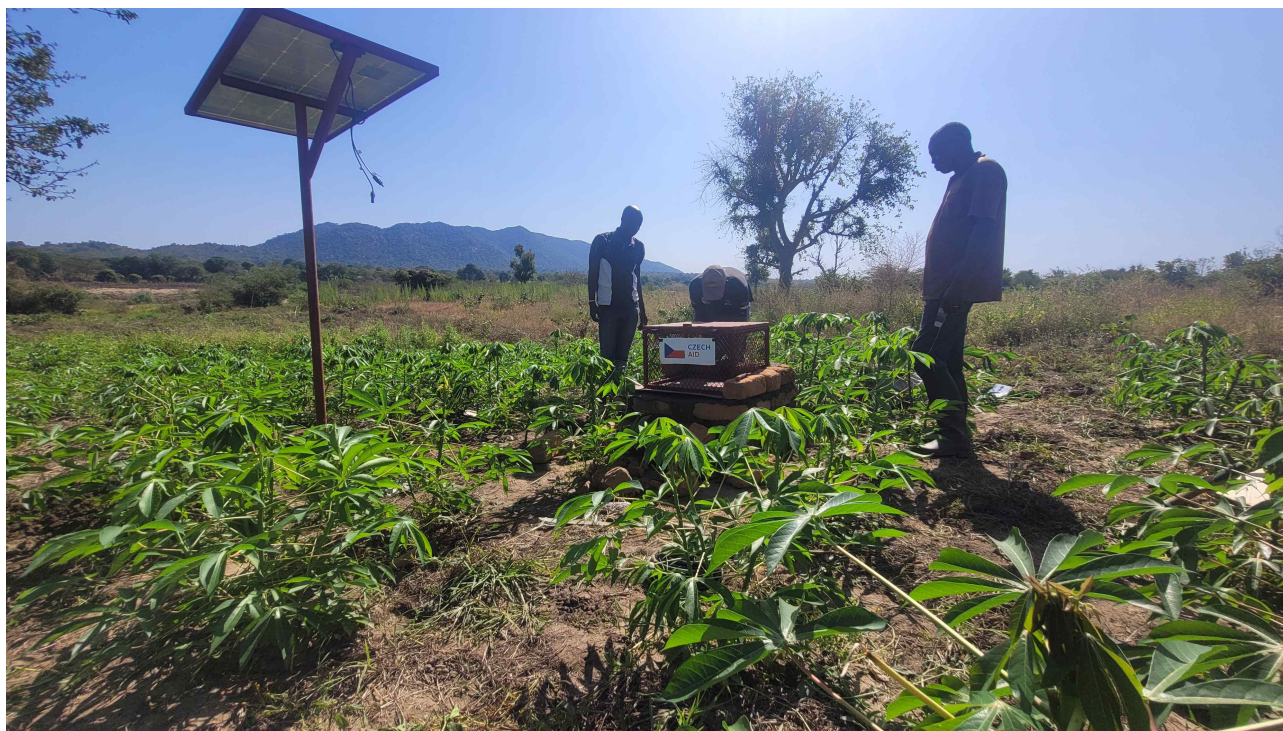
Instalace ostrovního solárního systému na poli manioku ve vsi Mbokomian
